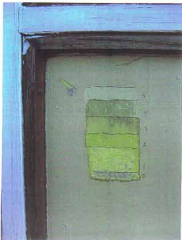
Fig. 14: Søholm III. Nr. 3. Lagvis afdækning udført på vægfelt under køkkenvinduet. Afdækning viser 6 farvelag, hvoraf det ældste (lag1) er et grøngul farvelag.
